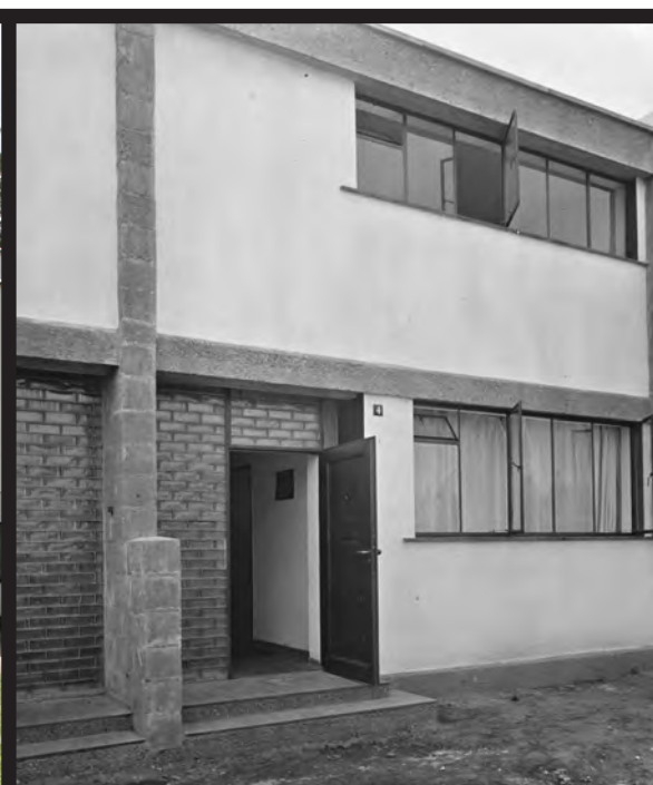
Siedlung Dessau-Törten, Architekt: Walter Gropius, 1926
